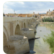
PUENTE ROMANO ROMAN BRIDGE
